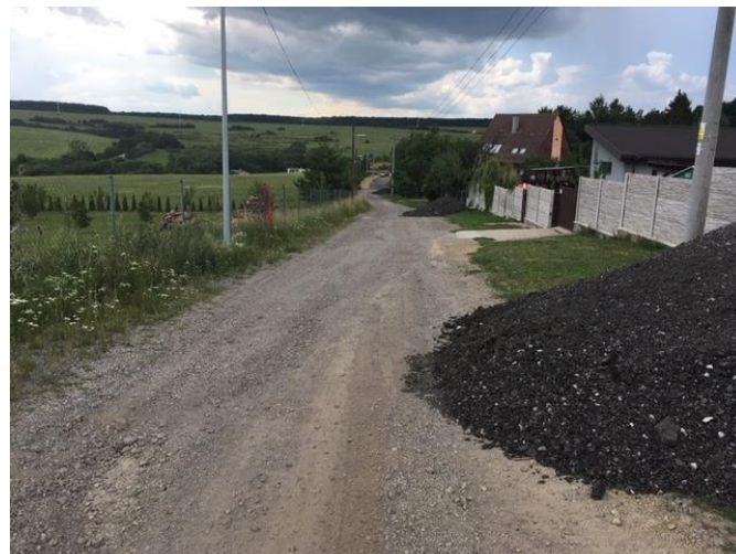
Obr. č. 2 Časť Sabinovskej s násypmi frézovaného asfaltu
